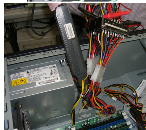
DC電源測定のクリップ等
